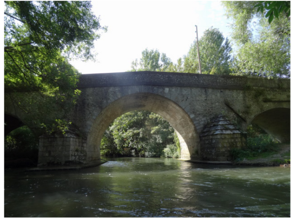
2 – Pont Saint-Jean – bras de décharge principal
