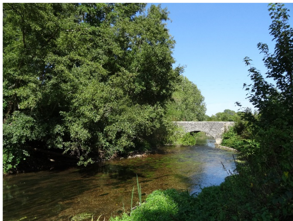
Figure 40 : Granulométrie grossière en amont des ouvrages (PCM, 14/09/2016)
