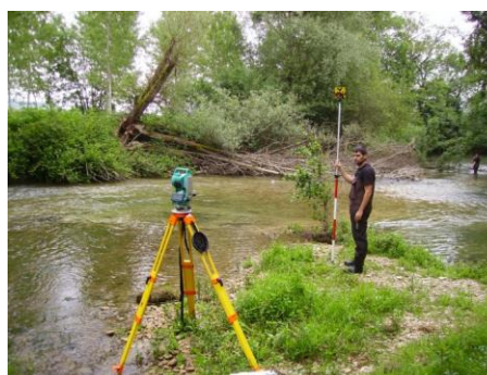
Utilisation d'une station totale (PCM)
