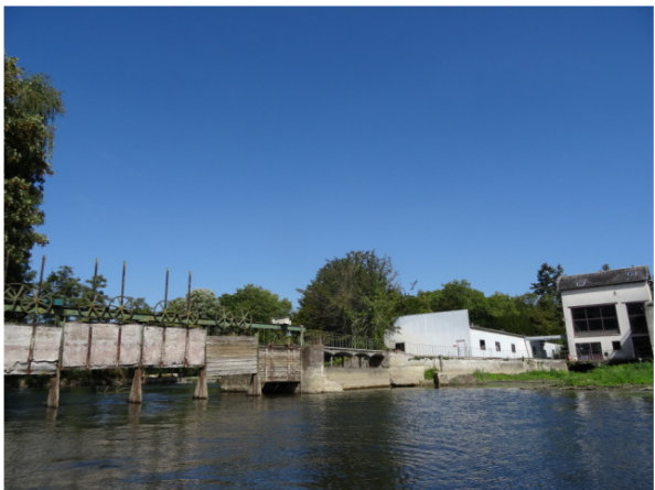
5 – Vannage et déversoir – vue amont
