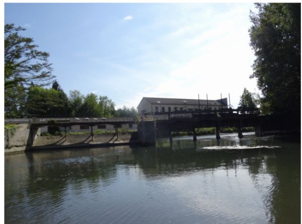
6 – Vannage et déversoir – vue aval
